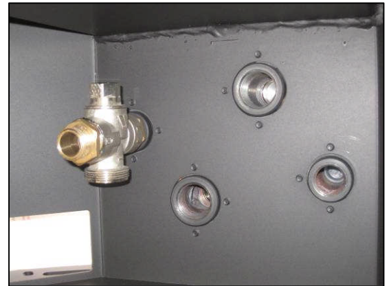
(Abb.: Montage der Thermischen Ablaufsicherung)
